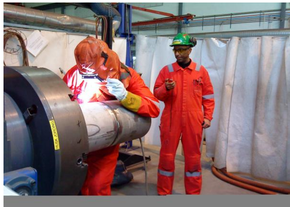
Måling av sveisehastighet med stoppeklokke
